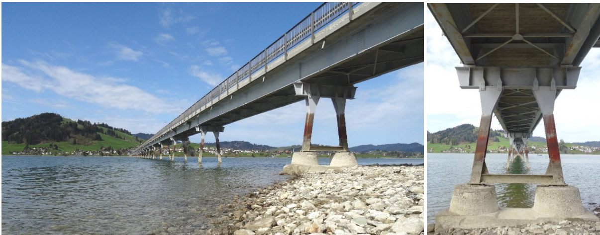
Bild 4. Eindrücke des Willerzeller-Viadukts (6. Mai 2017).
