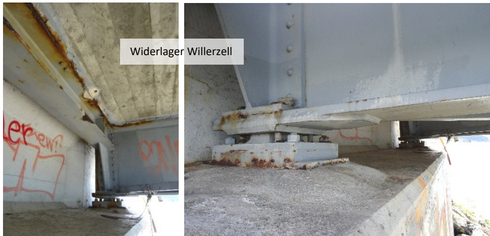
Bild 6. Allgemein noch guter Zustand des Korrosionsschutzanstrichs (6. Mai 2017)
