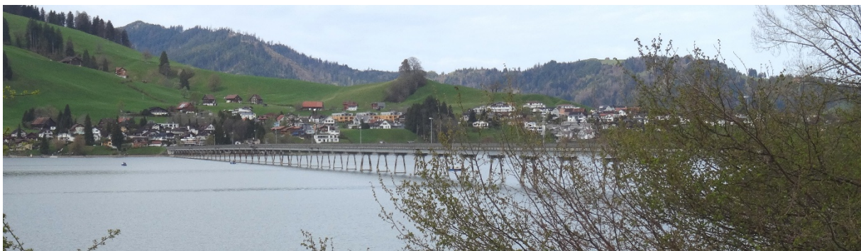
Bild 3. Ansicht des Viadukts von Willerzell aus (6. Mai 2017).
